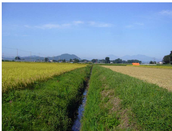
橋の上流 用水路
